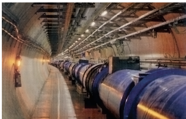
Рис.28. Круговой туннель, где ускоряются и сталкиваются протоны (CERN). Длина туннеля 27 км. Изучаются столкновения протонов, скорость которых достигает 99,99975% от скорости света. Происходит 30 миллионов столкновений в секунду. Движением протонов управляют 7000 сверхпроводящих магнитов
